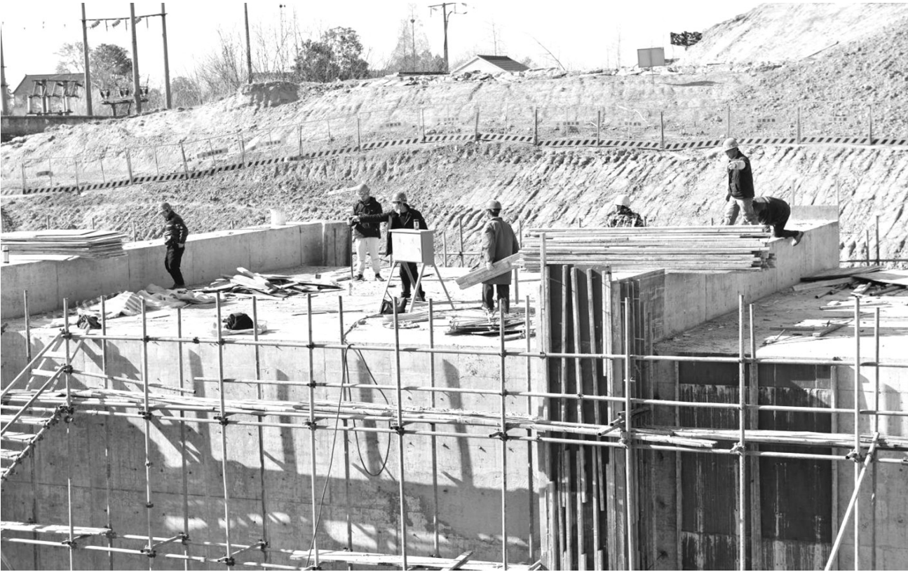
在省级重点水利工程的皖河泵站工程建设工地上,近百名工人复工就位,在多个作业面抓紧工程建设,确保该工程于今年4月30日之前完工。
