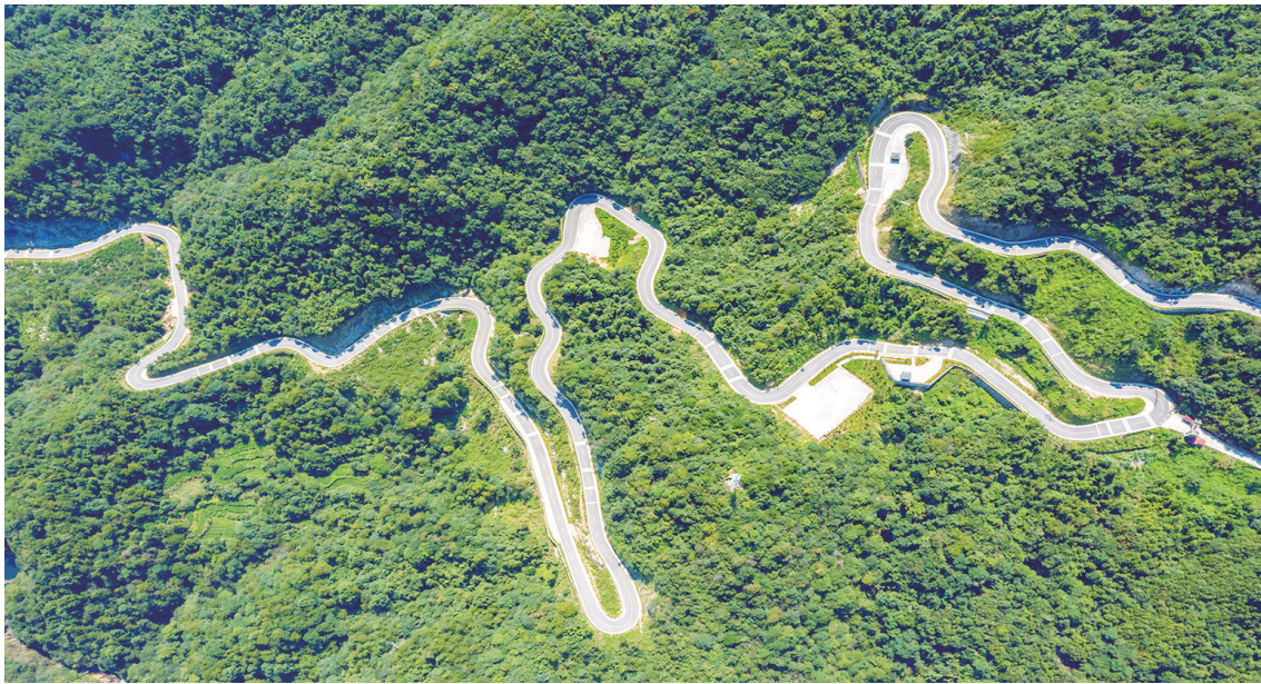
岳西县河图镇的天妙公路，位于大别山腹地，海拔1188米，全长20公里，连接天峡风景区和妙道山森林公园两大景点，是自驾游的热门路线。
