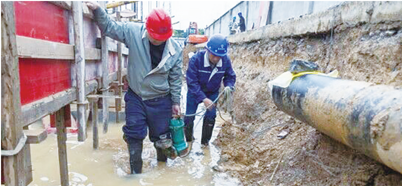
供水工作人员正在抢修供水管道。通讯员 颜春骏 摄
