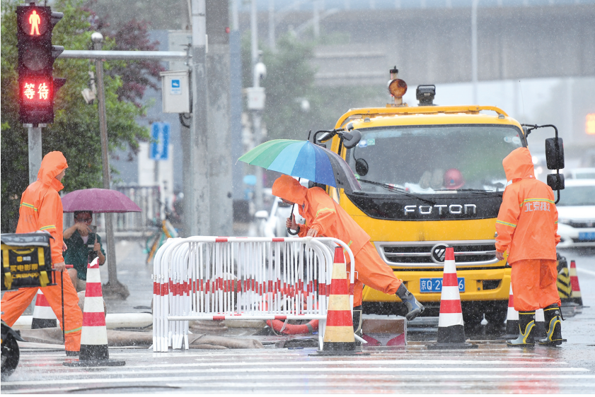
7月30日,在北京市朝阳区十里河桥附近,北京排水集团的工作人员在检查雨水井。
