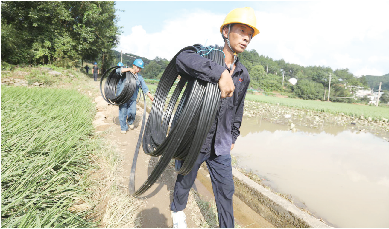
7月31日，国网潜山市供电公司电力工人正在抢修电力。 全媒体记者 徐火炬 摄
