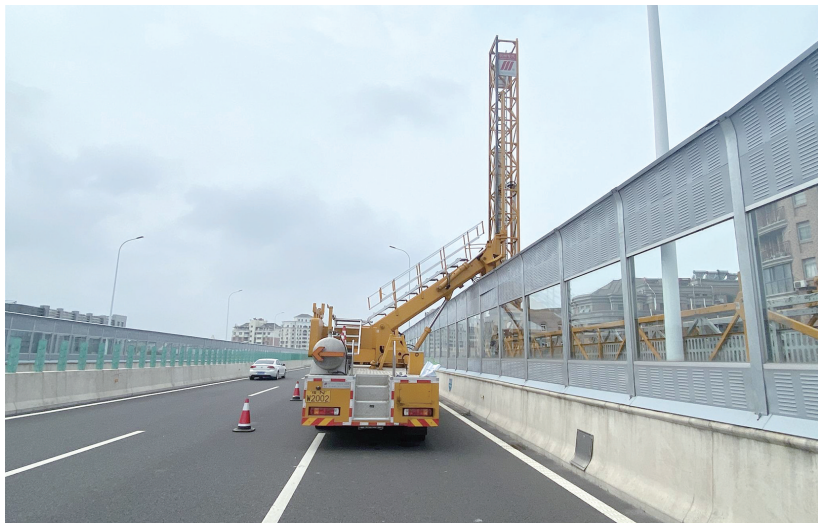
8月14日，检测车辆对中兴大道高架桥进行检测。通讯员 杨阳 摄
