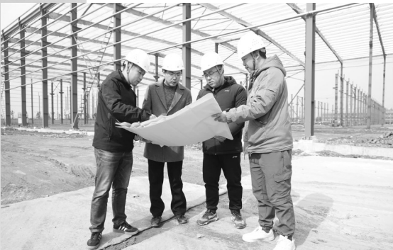
▲迎江经开区管委会工作人员深入企业建设现场协调解决问题 ◀即将投入使用的锦美星灿项目厂房 ▼锦美星灿项目生产线 通讯员 迎宣 摄
