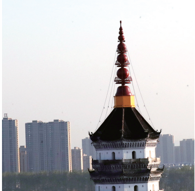
大雁飞过振风塔，成为每年候鸟迁徙的一道靓丽风景线。 全媒体记者 储永志 摄
