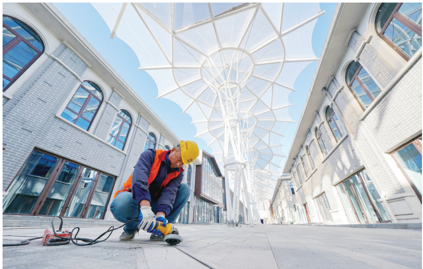
12月9日,工人在河北省唐山市路南区建国里老商业街改造项目建设现场施工。2023年以来,河北省唐山市路南区大力推进城市更新工程,围绕城市功能品质提升、公园城市生态修复等8大领域,实施城市原点片区改造提升等城市更新项目76个,推动城市高质量发展。 新华社记者 牟宇 摄
