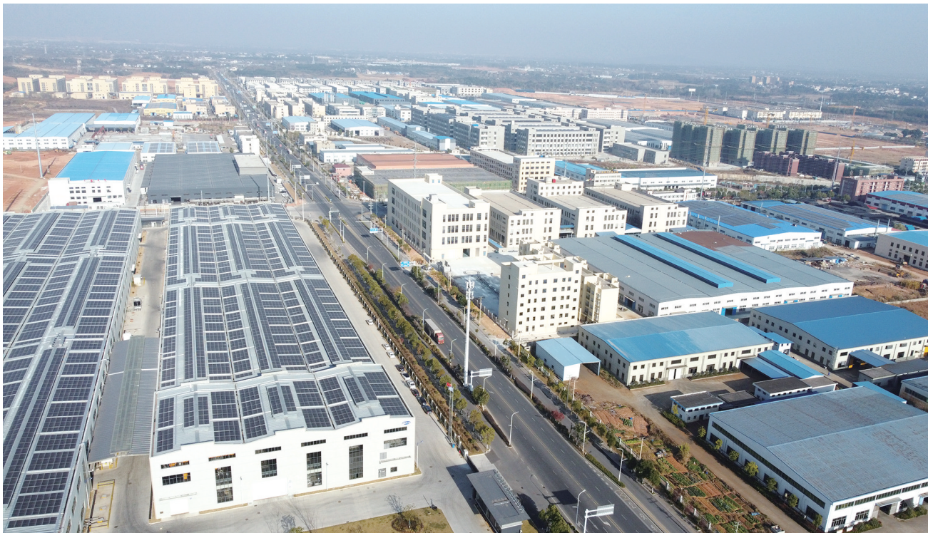
这是12月7日拍摄的怀宁经开区工业园（无人机照片）。 全媒体记者 徐火炬 通讯员 胡丹丹 摄
