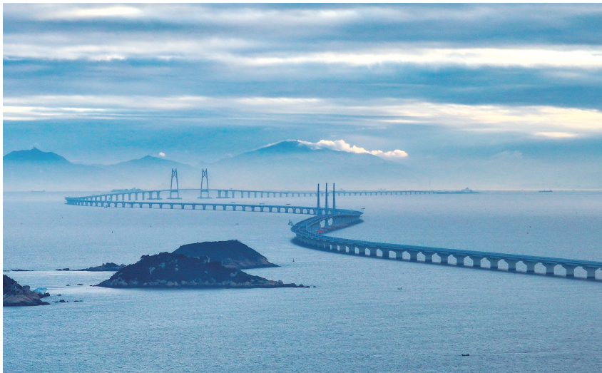
晨曦中的港珠澳大桥(2023年12月15日摄,无人机照片)。 新华社记者 刘大伟 摄
