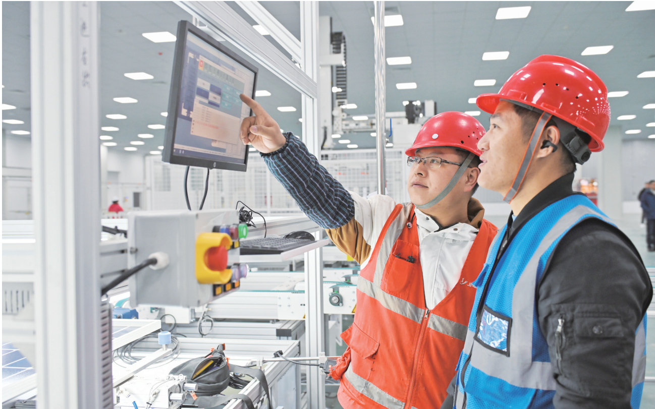
12月18日,潜山市晶优光伏3GW高效光伏组件生产制造项目生产车间,工作人员正在进行投产前设备调试。
