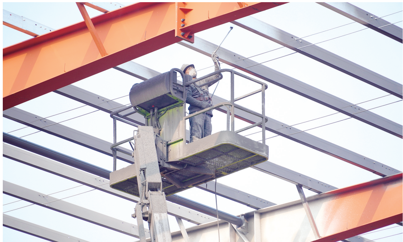
2023年12月29日,总投资52亿元的安庆祥路年产100万吨超强钢新材料项目现场,工人们正在加紧施工。 全媒体记者 路欣 通讯员 罗海霞 摄
