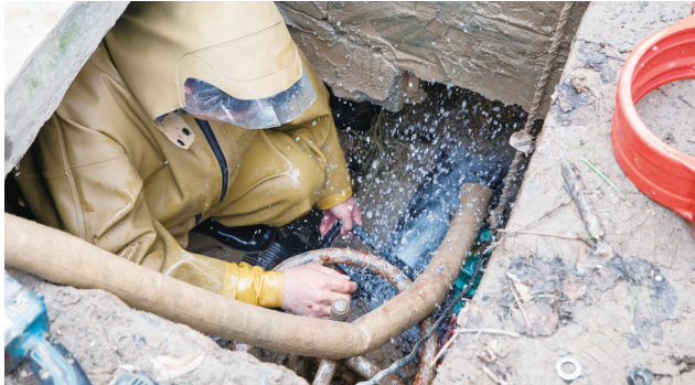
正月初九，供水人员正在吾悦华府小区抢修直径160的供水管道。
