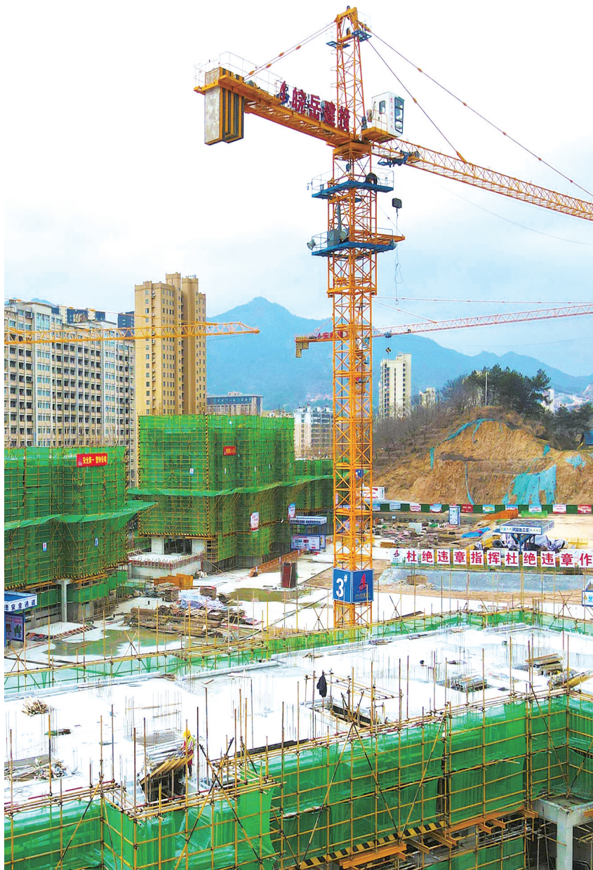
上图:2月18日,岳西县天竺镇一安置项目建设现场,工人们正在加紧施工。 通讯员 吴均奇 摄 左一:2月21日,太湖光华铝业制造公司智能化生产铝制构件车间,工人正在操控设备。 通讯员 刘辉 摄 左二:2月20日,在大观经开区凯锐化工科技有限公司园区内,工人驾驶叉车搬运货物。 通讯员 李劭 黄辛成 摄
