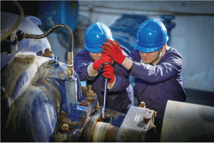
供水集团员工正在检修供水管道。通讯员 顾春骏 摄
