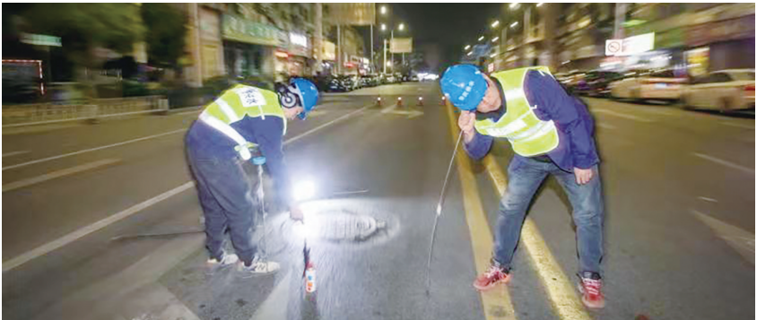
3月13日凌晨1时许,供水检漏人员正在巡查管线。
