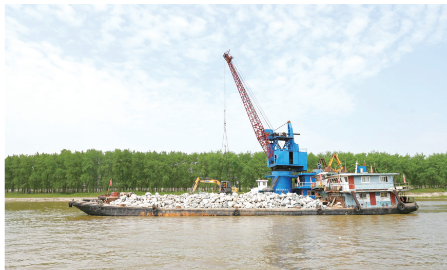
4月24日，在六合圩江段，施工船正在紧张施工，不停地将石料抛入江中，加固江堤。
