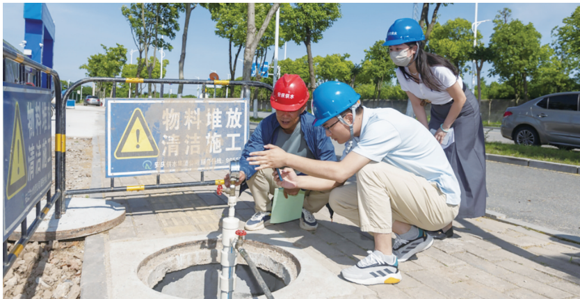
迎江工业园内环南路(元桥路—长风路)DN300管道试压。
