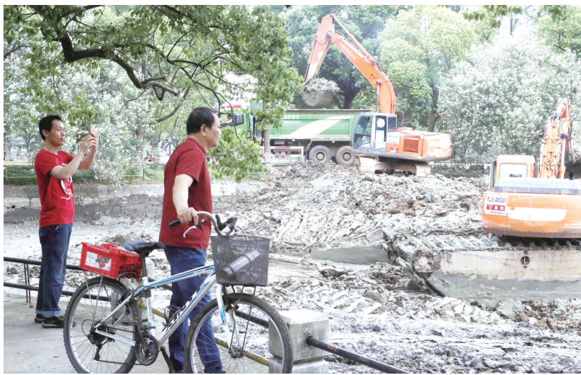
6月4日,菱湖公园机器轰鸣,菱湖清理湖底淤泥项目正在如火如荼进行,吸引一些市民驻足观望。该项目于5月中旬开工,预计6月中旬完成清淤任务。 全媒体记者 储永杰 摄
