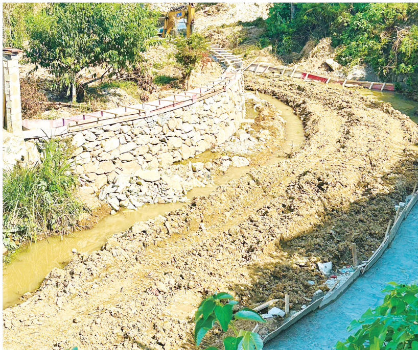
8月6日，在怀宁县江镇镇赵山村水保项目现场，挖掘机正在清理洪泥。赵山村利用项目资金60余万元，对村内一条主渠道进行修建，共清淤500米、新建水坝一座，打通农田灌溉最后一公里。
