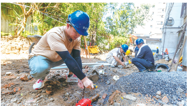
纺织西路小区管网维修改造。
