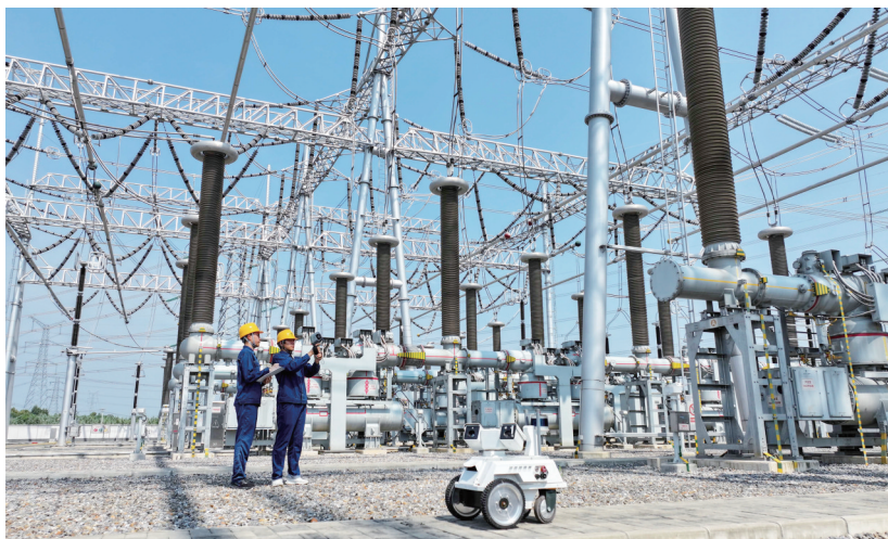
近期,安徽、江苏持续高温,用电负荷屡创新高。为加大跨区域送电力度,保障电网安全稳定运行和电力可靠供应,皖苏两省的电力工人联合对省际联络线及相关配电设施进行检修,并开展输变电设施巡视检查。
