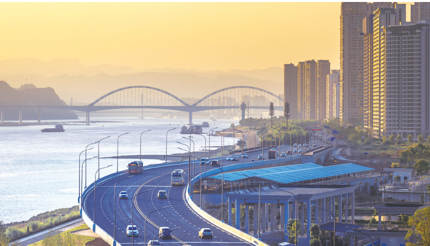
伍家岗长江大桥江景。三峡日报记者 刘昆 摄
