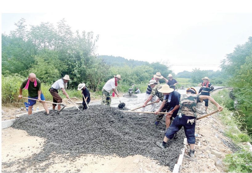
8月22日,在宜秀区五横乡虎山村村级道路硬化建设施工现场,10余名工人正在浇筑混凝土。此次五横乡共升级改造4条村组道路,进一步打通道路系统的“毛细血管”,在提升乡村整体形象的同时,有效地改善了周边3个村千余名群众的出行条件,让昔日群众的“忧心路”变为“暖心路”。 全媒体记者 黄有安 通讯员 陈虹 摄
