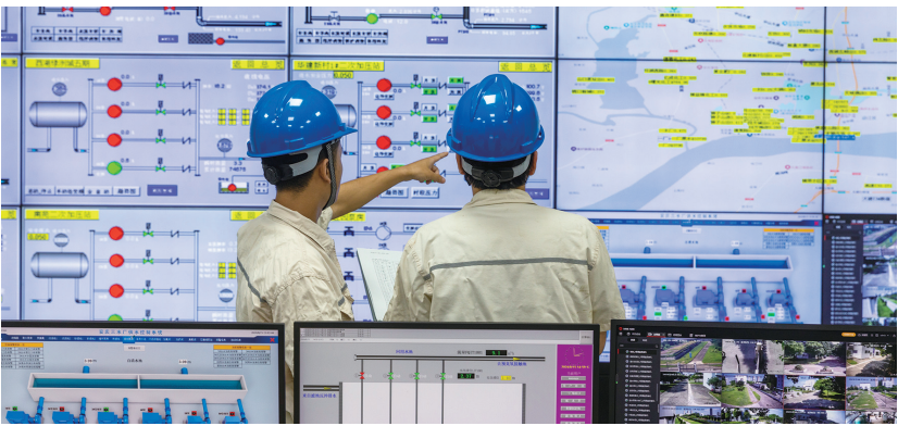
供水人员正在组织调度制水生产。
