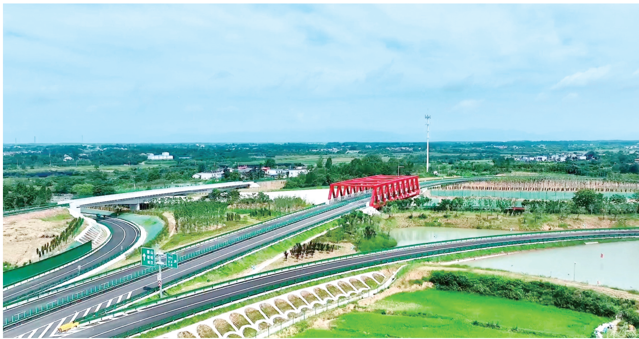
9月3日上午，G50沪渝高速公路怀宁西互通立交开通运营。 通讯员 张世琪 摄
