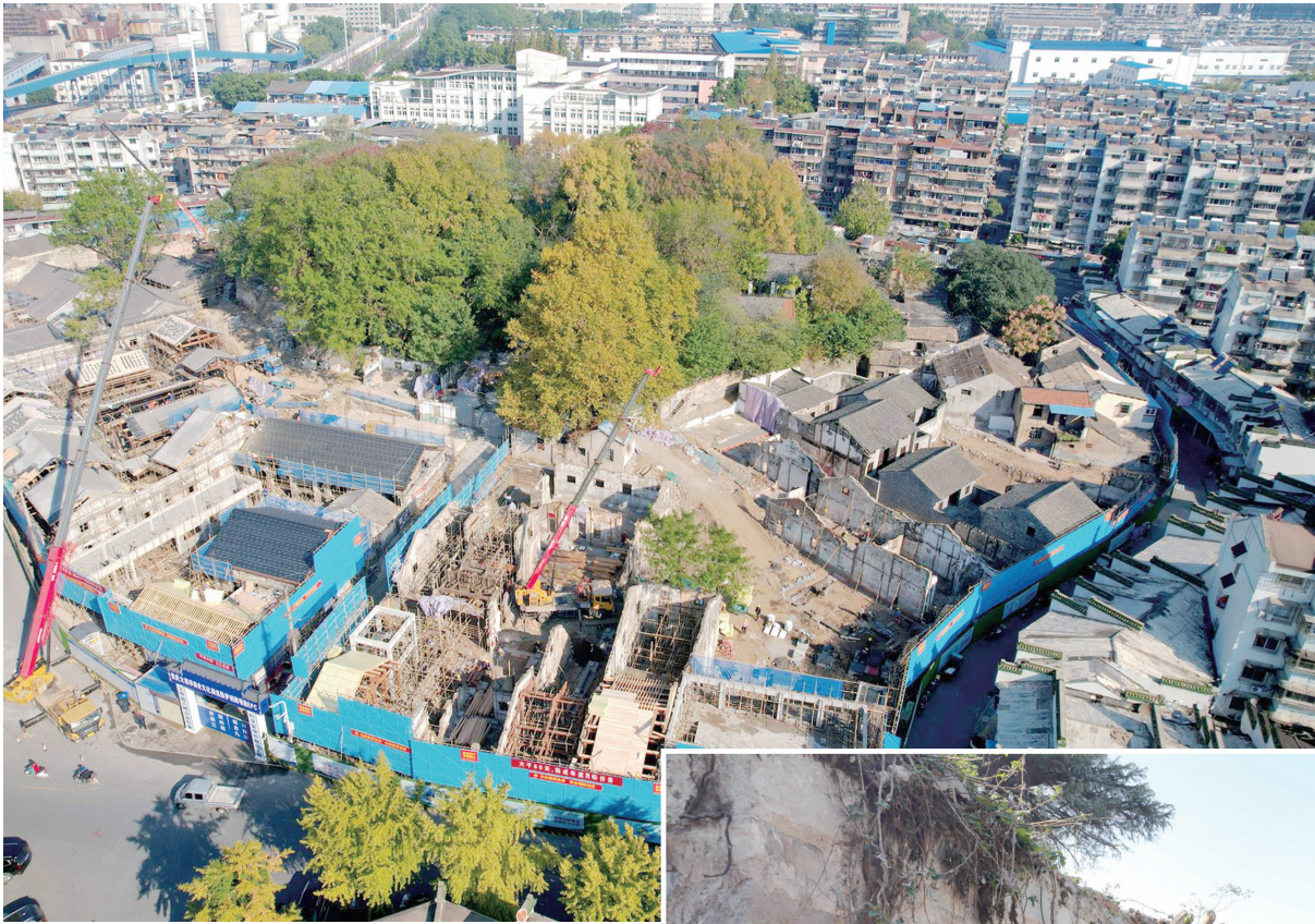
▲ 11月7日，大观亭历史文化街区保护利用项目施工现场。
