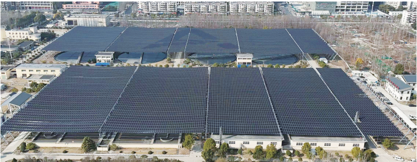
魏家咀污水处理厂分布式光伏发电项目。
