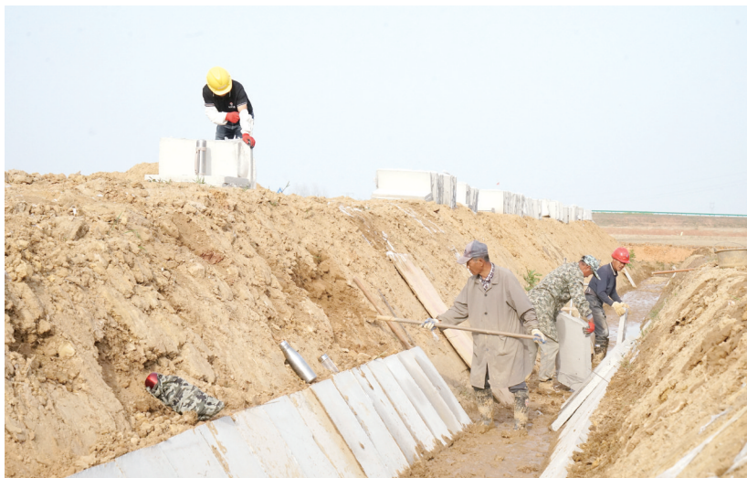
4月5日，怀宁县雷埠乡农田水利及小流域治理工程现场，工人在加紧施工。当地抢抓汛前施工窗口期，全力推进水利项目建设。 通讯员 檀志扬 吴焕天 摄
