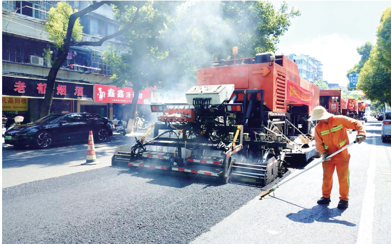
施工人员正在利用就地热再生技术助力华中西路焕新升级。 全媒体记者 徐志远 摄
