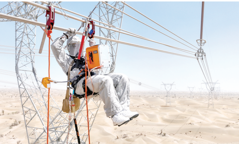
在且末-若羌750千伏线路，电力员工开展带电消缺作业。 新华社发
