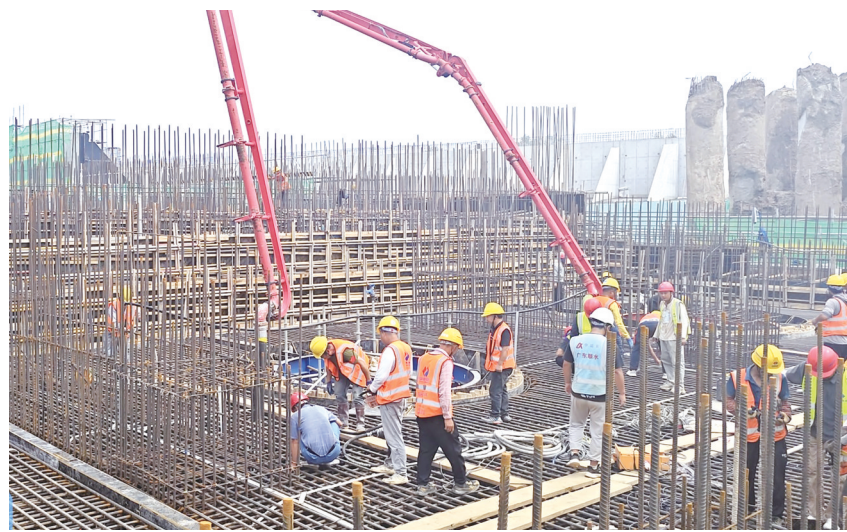
华阳河蓄滞洪区工程建设现场。 全媒体记者 沈永亮 摄
