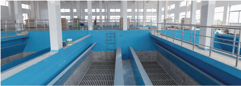
在建的一水厂二期工程过滤池。通讯员 顾春骏 摄
