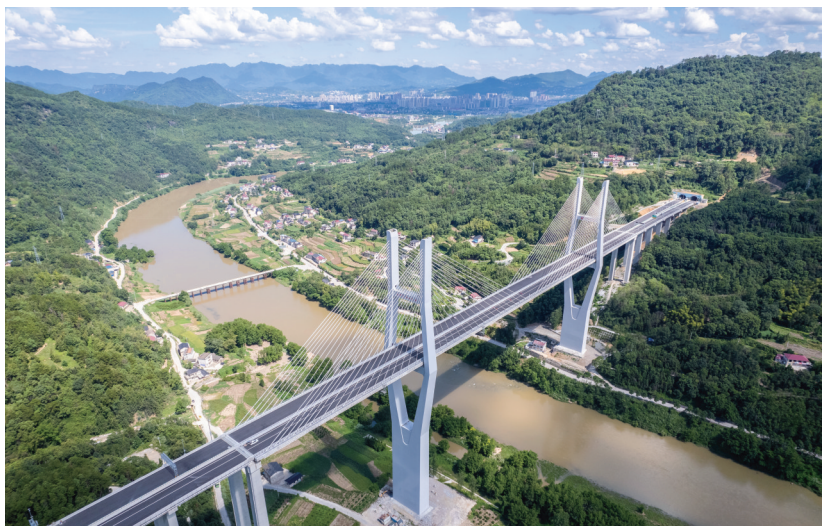
这是8月19日在湖南炉慈高速建设施工现场拍摄的长潭河湊水大桥。 近日,湖南炉慈高速公路建设进入联调联试收尾阶段,技术人员正抢抓工期做好全线机电设备的安装及调试工作,为9月底如期建成通车奠定基础。项目通车后,将作为一条便捷的旅游通道,从北至南依次连接长江三峡、国家级自然保护区壶瓶山、世界自然遗产地张家界。 新华社记者 陈思汗 摄
