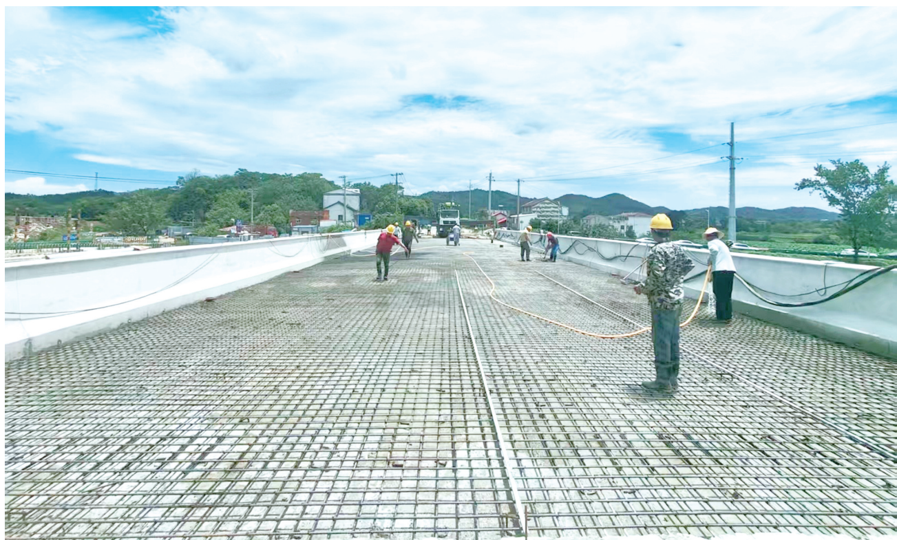
图为5月中旬，新练潭大桥开展桥面铺装施工。 通讯员 张秋晨 摄
