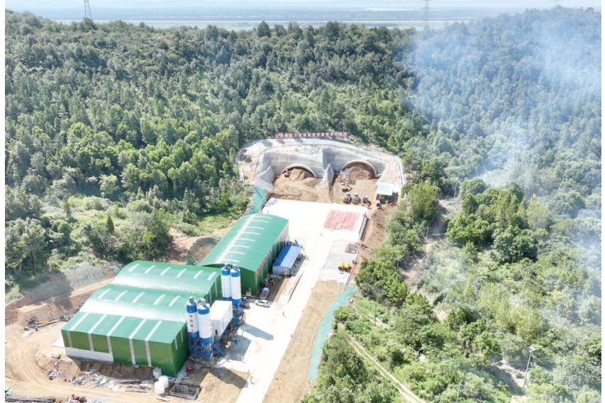
8月26日，新安岭隧道施工现场。全媒体记者 白萍 摄
