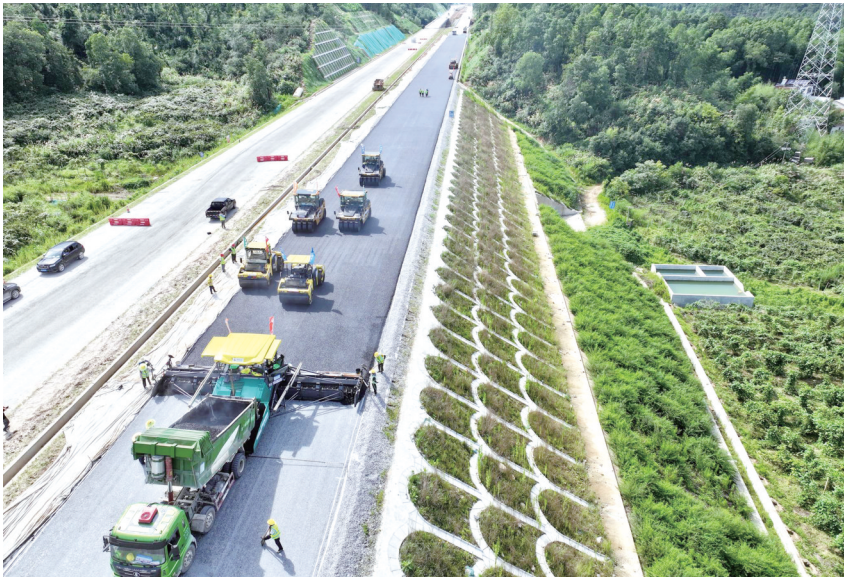
在太蕲高速安徽段项目现场,施工人员正在铺设沥青。 通讯员 刘守苗 摄
