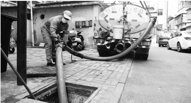
大观区四方城街化粪池清淤。
