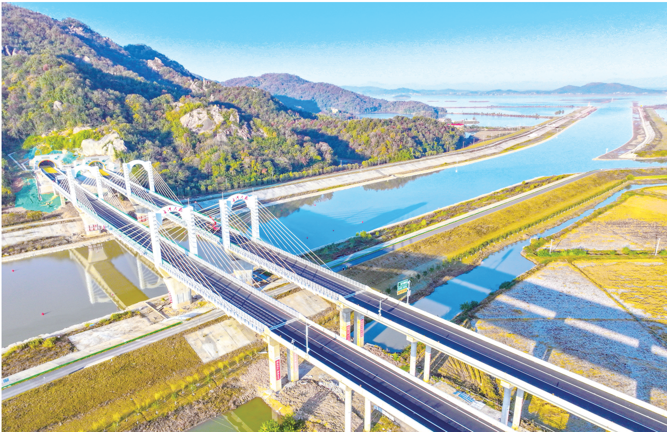
G4231宁九高速长河特大桥段（无人机照片）。 通讯员 沈筠 摄
