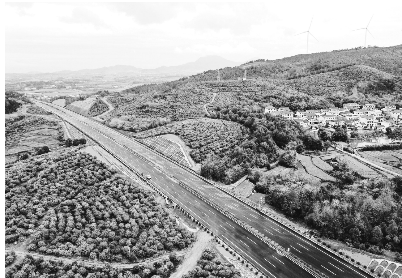
图为新修的S246省道穿越太湖县徐桥镇、大石乡。
