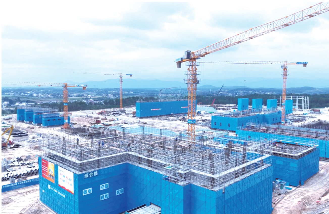
宿松换流站项目施工现场。 通讯员 廖德 摄
