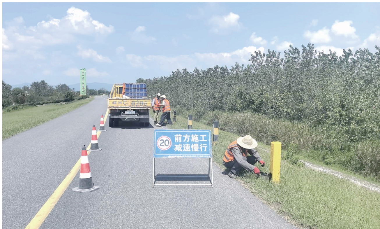
安广江堤交通安全设施提级改造工程施工现场。 通讯员 张进 摄
