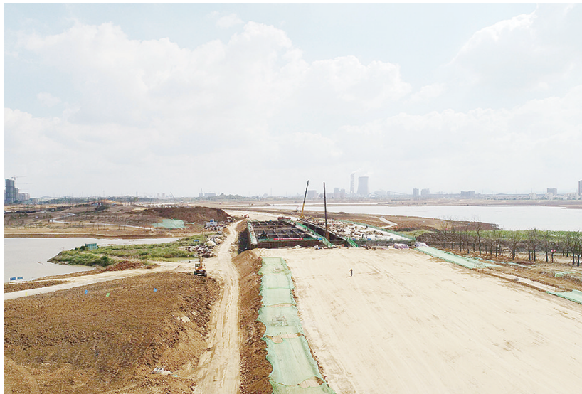
9月22日,秦潭湖环境综合整治工程项目施工现场。据了解,截至目前,项目清淤已全部完成,土方平衡完成95%,园路路基完成95%,绿化苗木栽植完成5%,雨水管道完成95%,桥梁下部结构完成,东、西桥现浇箱梁施工,景观桥上部钢结构施工,园建、公厕及管理用房等工程施工正在进行。
