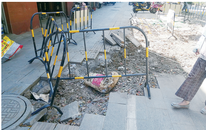
图为被开挖的路面
