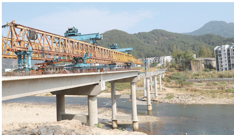
S361店前至水吼公路潜山段改建工程属潜山市重点工程,目前已完成20片箱梁预制,正在进行大桥梁板第二联4跨梁板安装,预计12月底完成全部28片箱梁吊装。 储亚林 贾廉锋 摄
