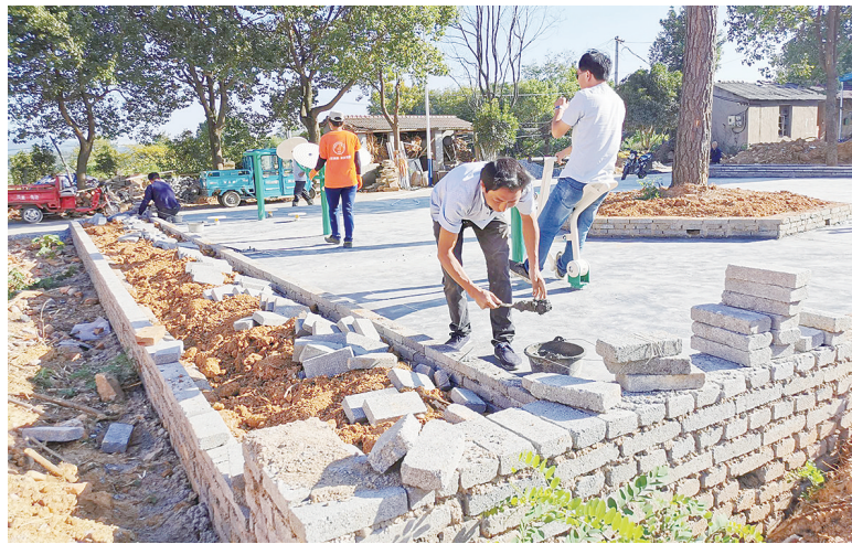
连日来,怀宁县凉亭乡凉亭社区学堂组广场,工人正在进行工程收尾。凉亭社区结合农村人居环境整治,在原场地建成近300平方米的小广场。为群众丰富精神文化生活创造良好条件。(何汀)
