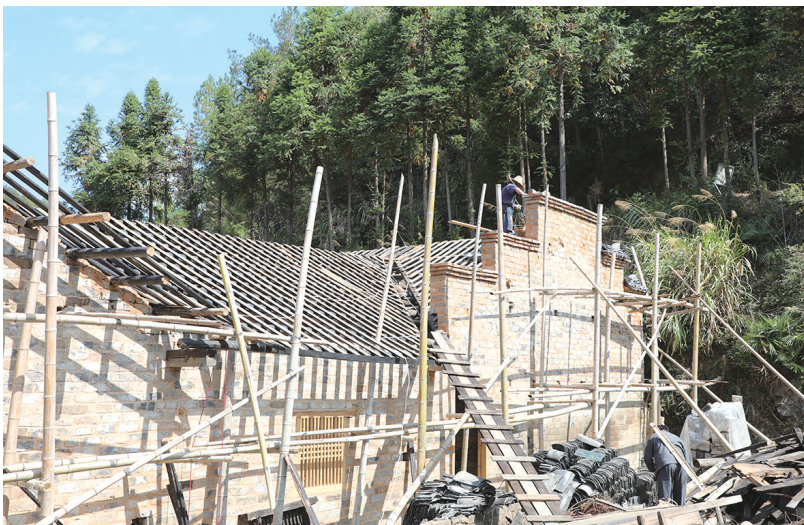
图为正在修缮的殷家老屋
