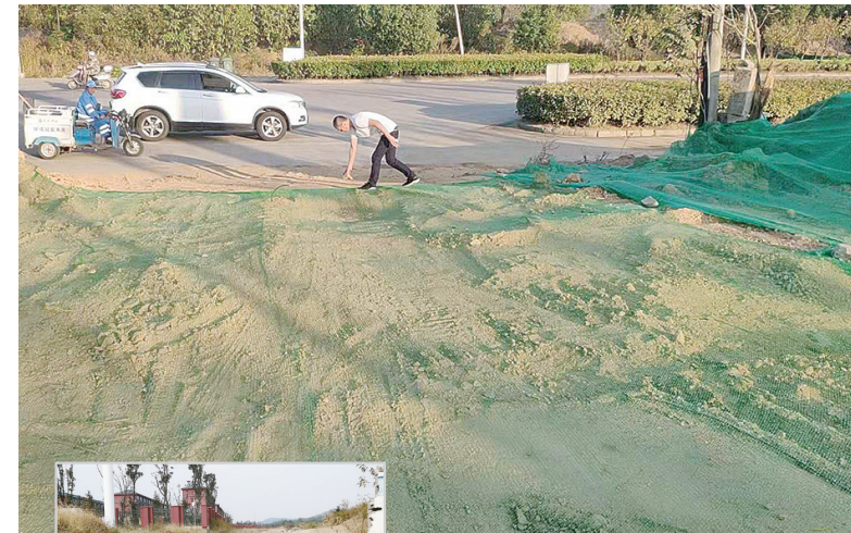
↑上图为整改后工地出入口。 ←左图为整改前工地出入口。
