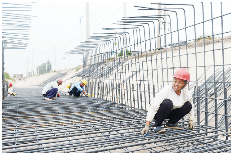
10月23日,安徽农垦华阳河农场道路和雨污分流管网改造现场。该农场在实施雨污分流建设的同时,投资2000万元,对场内六个社区的交通干道进行拓宽改造,打造美丽宜居新社区。 李龙 摄
